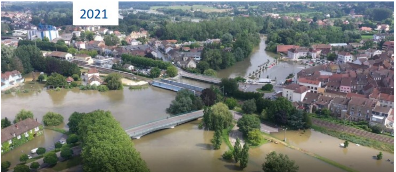
Crue de la Seille à Louhans en 2021 (image DDT)
